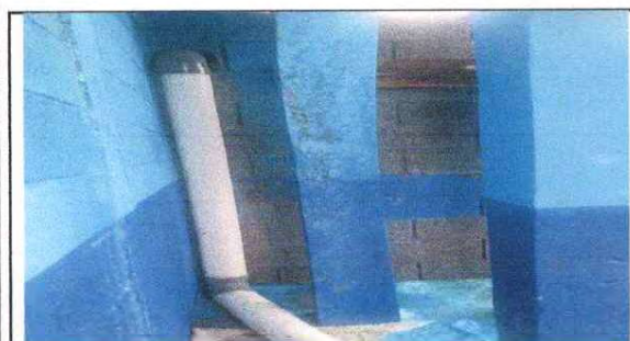
FOTO 3: Sustitución de tubería PVC línea principal aguas negras EN BAÑOS
