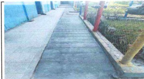
FOTO 16: Sustrucción de piso de Tierra por piso de torta de concreto EN PATIO
