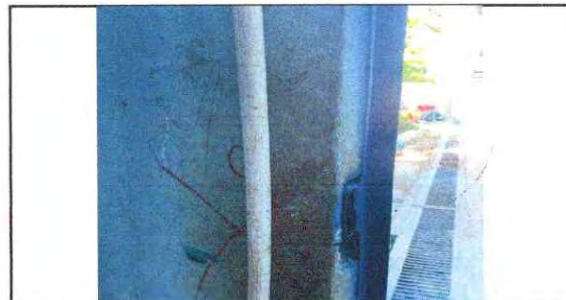
FOTO 6: Sustitución de tubería línea principal EN COCINA
