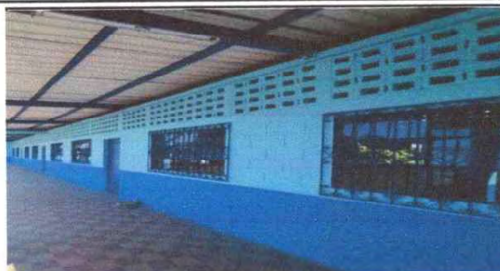
FOTO 14: Pintura en muros exteriores EN AULAS
