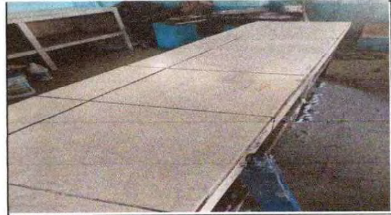
FOTO 8: Reparación de azulejo en muebles de cocina 25x20cm EN COCINA
