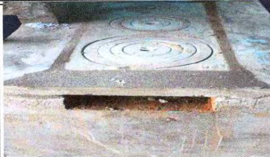
FOTO 7: Sustrución de estufa rural (completa) incluye chimenea y plancha de metal EN COCINA
