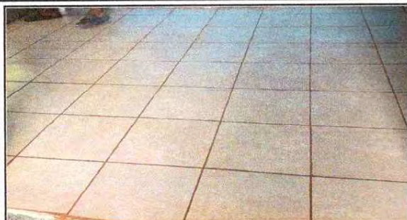
FOTO 1: Sustitución de piso de torta de concreto Por piso Ceramico (antideslizante) EN MODULO AULA 10
