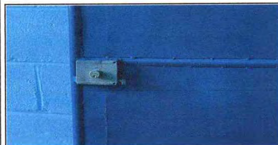
FOTO 5: Sustitución de chapa EN COCINA
