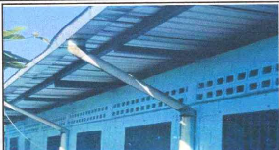
FOTO 13: Sustrucción de canal de metal aula no.7 Y Sustrucción de bajada de agua pluvial de metal por tubo PVC 3"
