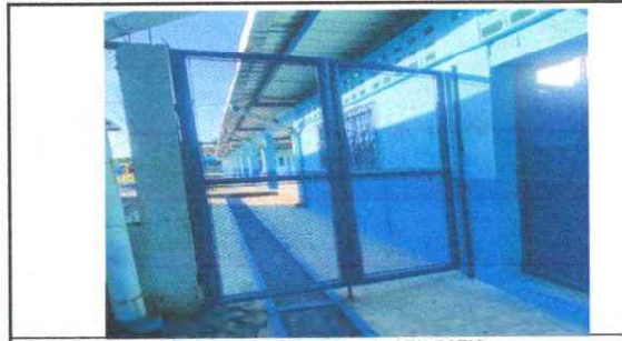
FOTO 18: Mantenimiento a portones de metal EN PATIO
