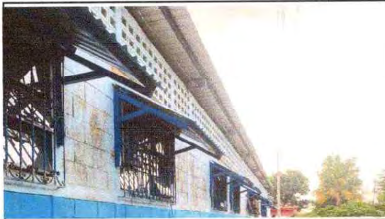
FOTO 9: Sustrución de lámina, por lámina troquelada aluzinc calibre 26 Y Sustrución de estructura de soporte de madera, por metal EN AULAS
