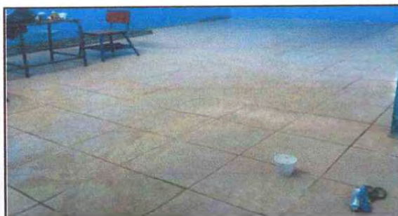
FOTO 15: Sustrucción de piso de torta de concreto Por piso Cerámico 30x30cm EN MODULO AULA 10
