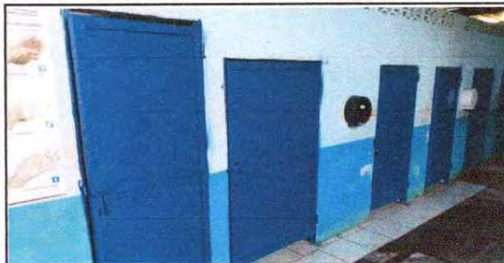
FOTO 2: Mantenimiento a estructura (lijado, cambio de tubo , cepillado, sujeciones, aplicación de pintura) a puertas servicios sanitarios
